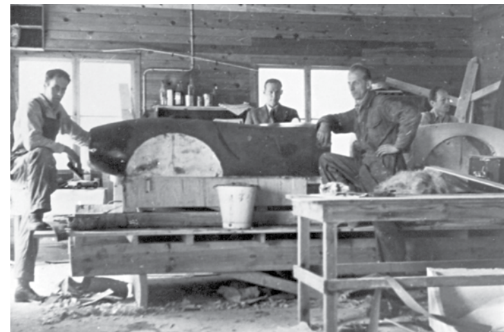
Ladan i Åsaka var så långt ifrån en bilfabrik man kunde komma. Här byggdes ”pluggen” i gips för den senare karossgjutningen.
