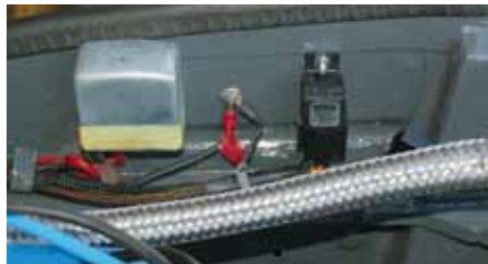
Installation av relä nära generatortorn
