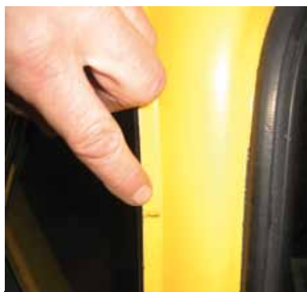
Revner i fiber ved tagrenden skal fræses op til 2-5 mm. Og fyldes med epoxy
