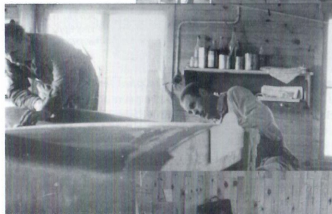
Elis Olsson och Sven Fredriksson putsar trägipsmodellen vilken användes som modell för plastkarossen. Bilden är tagen i ladan i Åsaka 1955.
