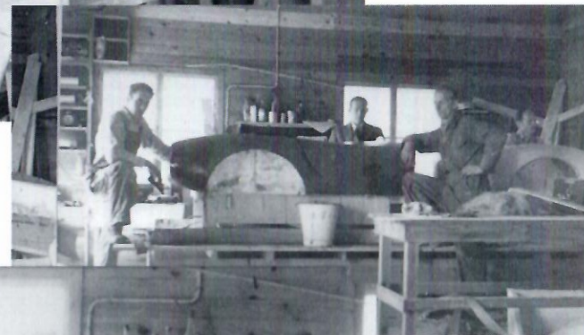
Elis Olsson och Sven Fredriksson putsar trägipsmodellen vilken användes som modell för plastkarossen. Bilden är tagen i ladan i Åsaka 1955.
